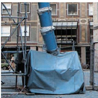
Zur Abschirmung gegen Staub und auflprallenden Schutt gibt es eine Containerabdeckplane sowie Staubschutzmanschetten. Pos. 18
