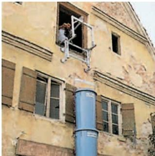
Der Aufbau bei grösseren Höhen wird durch die Handwinde erleichtert (max. Aufbauhöhe 40 m). Pos. 12
