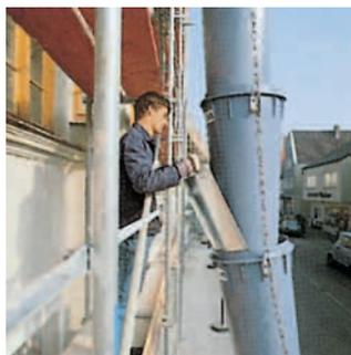
Nachträgliches Einsetzen eines Verschleisseinsatzes. Pos. 15
