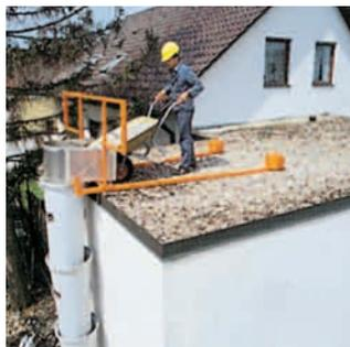
Ein zerlegbarer Rahmen mit Ballastgewichten ermöglicht den Einsatz am Flachdach. Pos. 7
